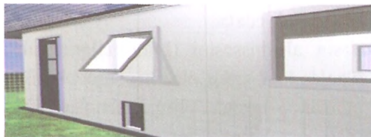
Şəkil 3. bildirçinləri saxlamaq üçün bina
